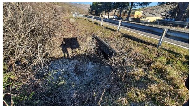
Figura 19- Imbocco del tombamento del fosso di Bugliole
