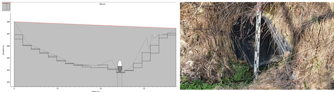
Figura 14- Imbocco del tombamento del fosso del Becco
