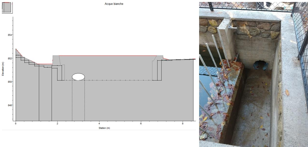
Figura 15- Imbocco del tombamento del fosso delle Acque Bianche con griglia a pettine
